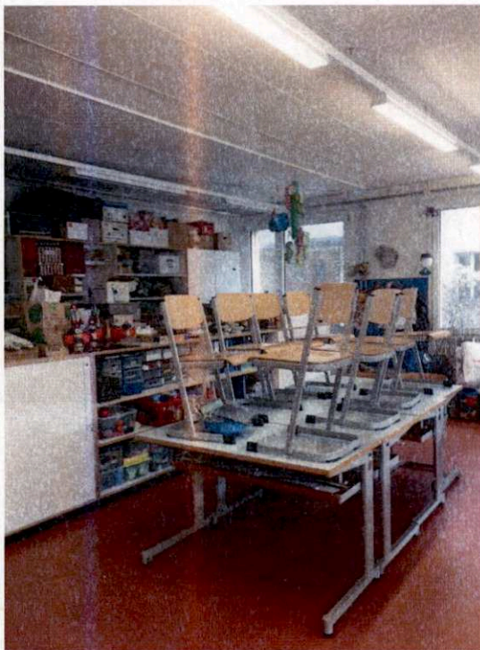
Eclairage par tubes fluorescents et sol linoleum préinstallés
