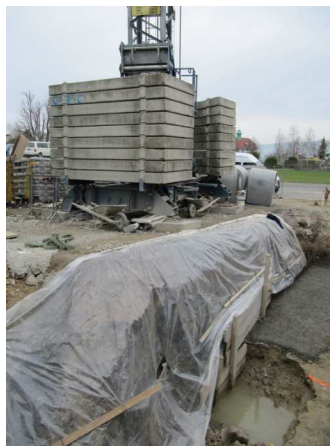
Imm. Sogeprom = garde-corps non conformes (visiteurs !) Fouille au pied de la grue ! Consolider+étayer ..
