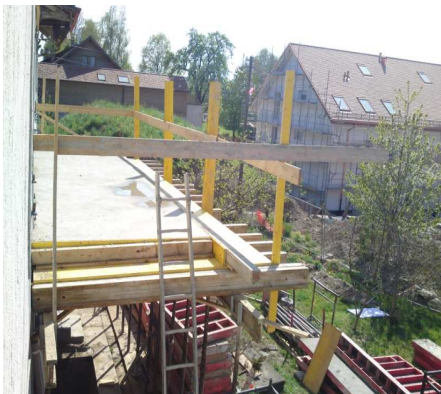
Imm. Sogeprom = garde-corps non conformes (visiteurs !) Fouille au pied de la grue ! Consolider+étayer ..
