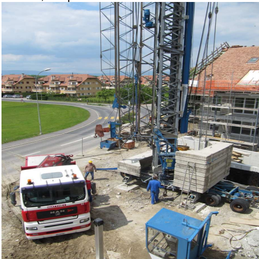
démontage grue / proximité domaine public
