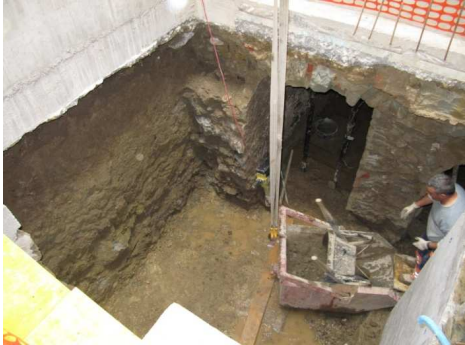
Reprise en sous-œuvre
