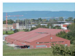
Le Centre sportif des Marais
