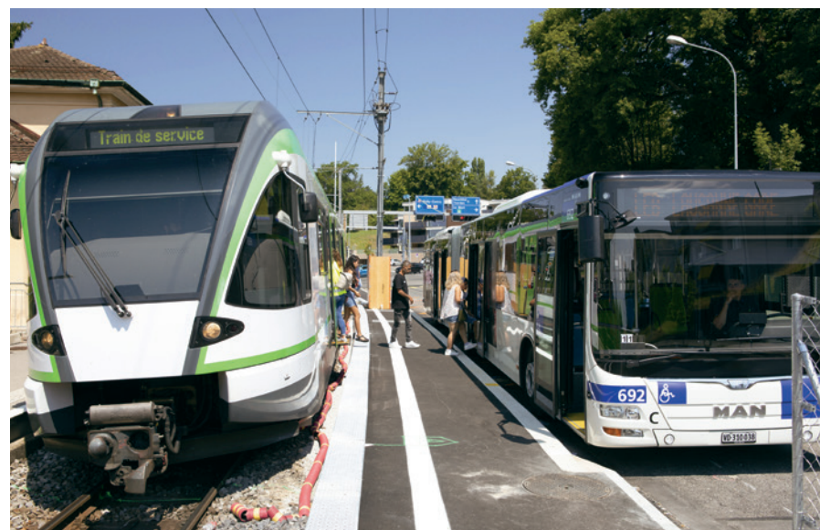
Dès le 25 septembre, et durant environ 200 jours, les trains du LEB seront remplacés par des bus entre Prilly-Chasseur et Lausanne gare.
