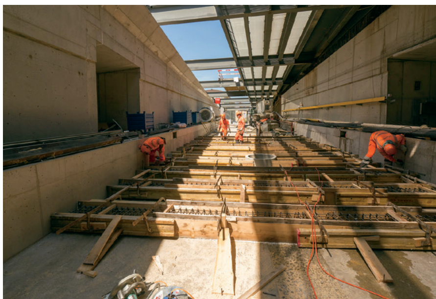
Les travaux de finalisation du tunnel permettront de raccorder le tronçon existant, entre Chauderon et le Flon, au nouvel ouvrage, creusé entre Union-Prilly et Chauderon.
